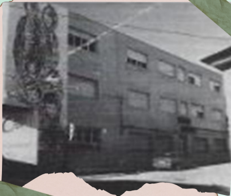
FACHADA DEL ANTIGUO CENTRO DE FP
