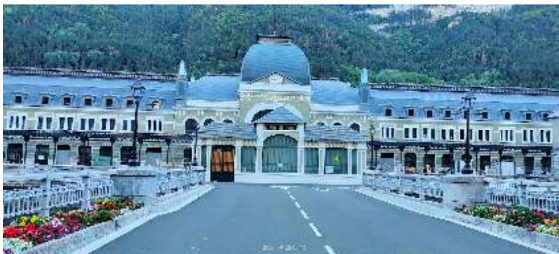
ESTACIÓN DE CANFRANC. Foto Montoro
